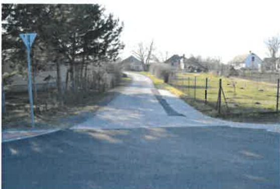
14.kép: Csatlakozás a Fő u. felújított burkolatához (Fő u. irányból).
